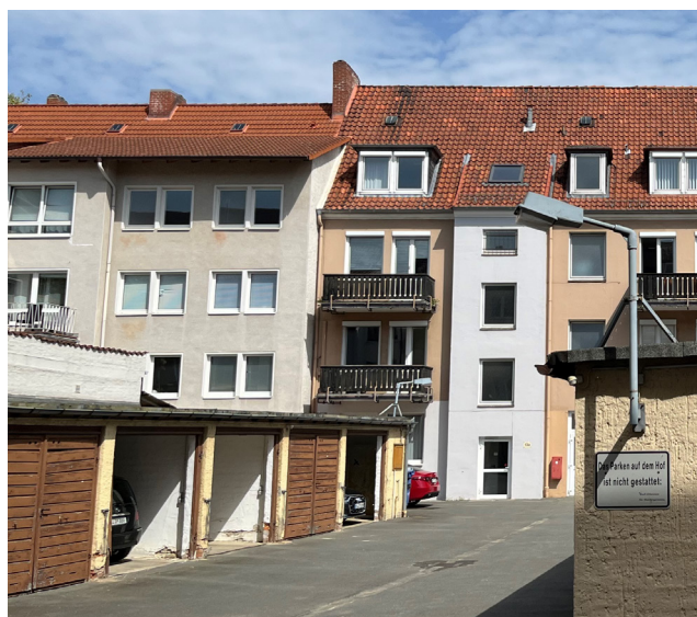
Versiegelte Innenhöfe im Block zwischen der Jakobi- und der Marktstraße
